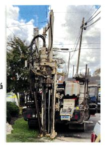
complete el muestreo, las perforaciones se rellenarán y la superficie se restaurará a su material original (por ejemplo, grama, gravilla, asfalto, concreto). El público debe esperar ruidos altos cuando se taladre en el suelo y la presencia de camiones con equipo auxiliar durante el muestreo (entre 8 am y 5pm de Lunes a Viernes).
